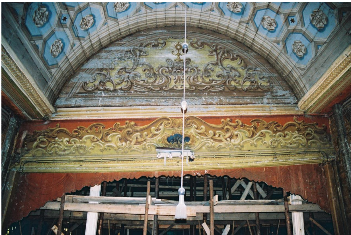
Fot. 3. Kościół p.w. Św. Mikołaja w Truskolasach . Ściana tarczowa nad wejściem do kaplicy. Odspojenia i ubytki powłok barwnych odsłaniające powierzchnię drewna.
