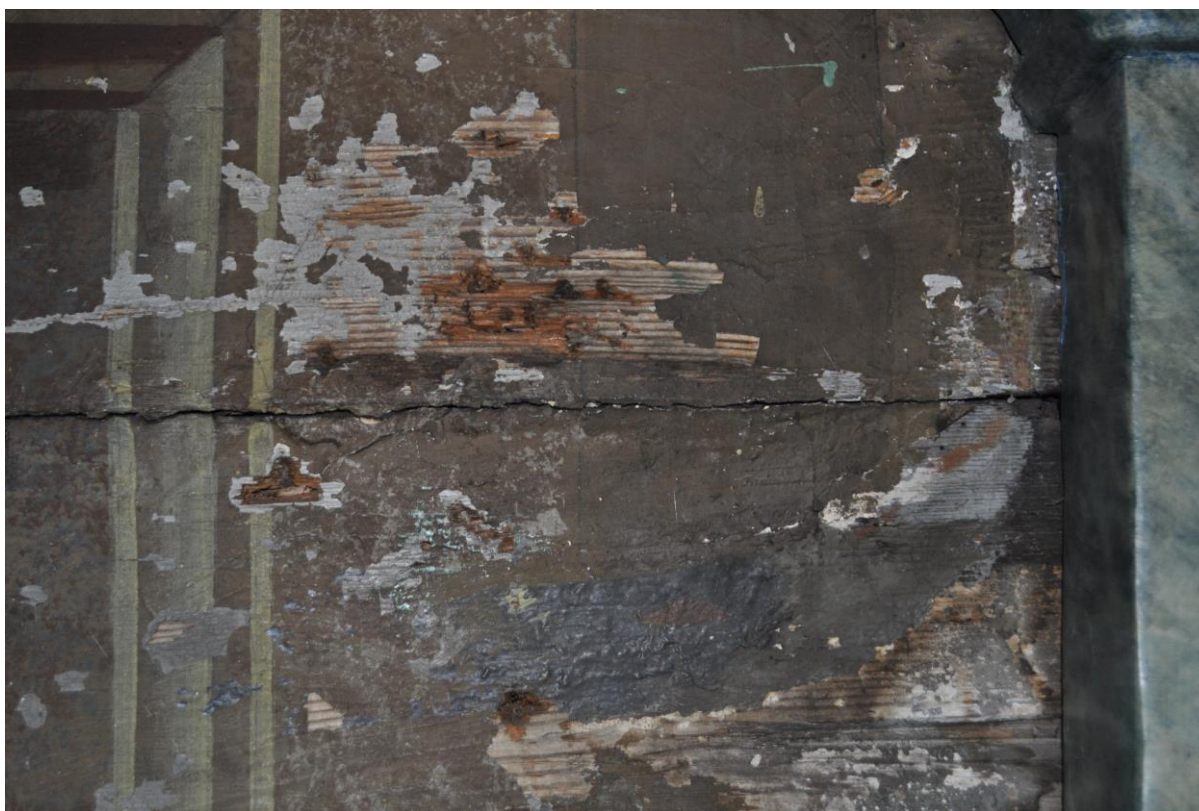
Fot. 6. Kościół p.w. Św. Mikołaja w Truskolasach. Szczeliny na połączeniach drewna. Ubytki i uszkodzenia warstw malarskich w partii cokołowej odsłaniają podłoże.
