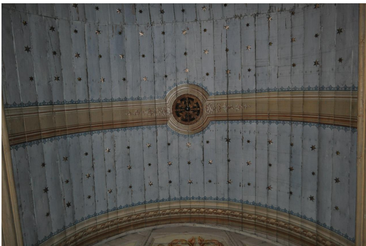
Fot. 10. Kościół p.w. Św. Mikołaja w Truskolasach . Pozorne sklepienie kolebkowe. Rozspojenia na połączeniach drewna. Ubytki, odspojenia i spękania kitu i powłok barwnych.
