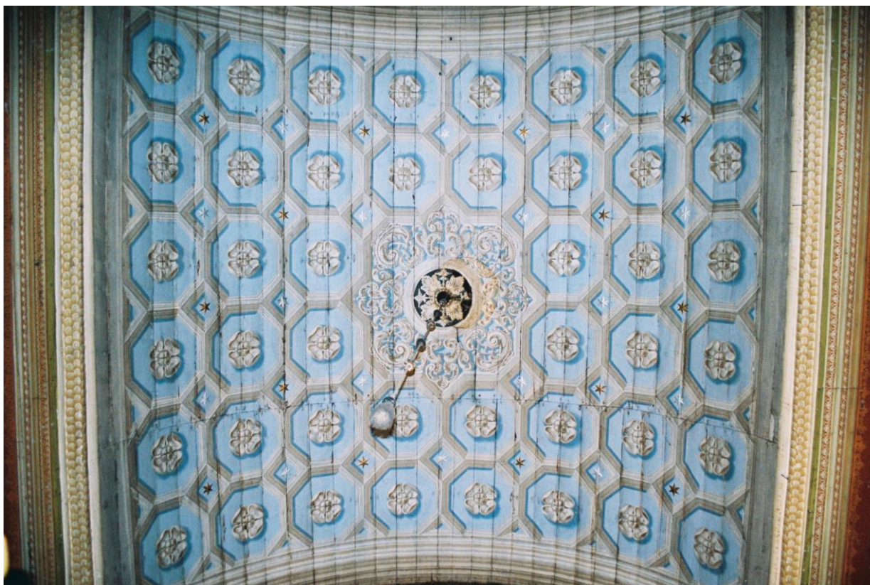
Fot. 4. Kościół p.w. Św. Mikołaja w Truskolasach . Pozorne sklepienie kolebkowe. Rozspojenia na połączeniach drewna. Ubytki, odspojenia i spękania kitu i powłok barwnych.
