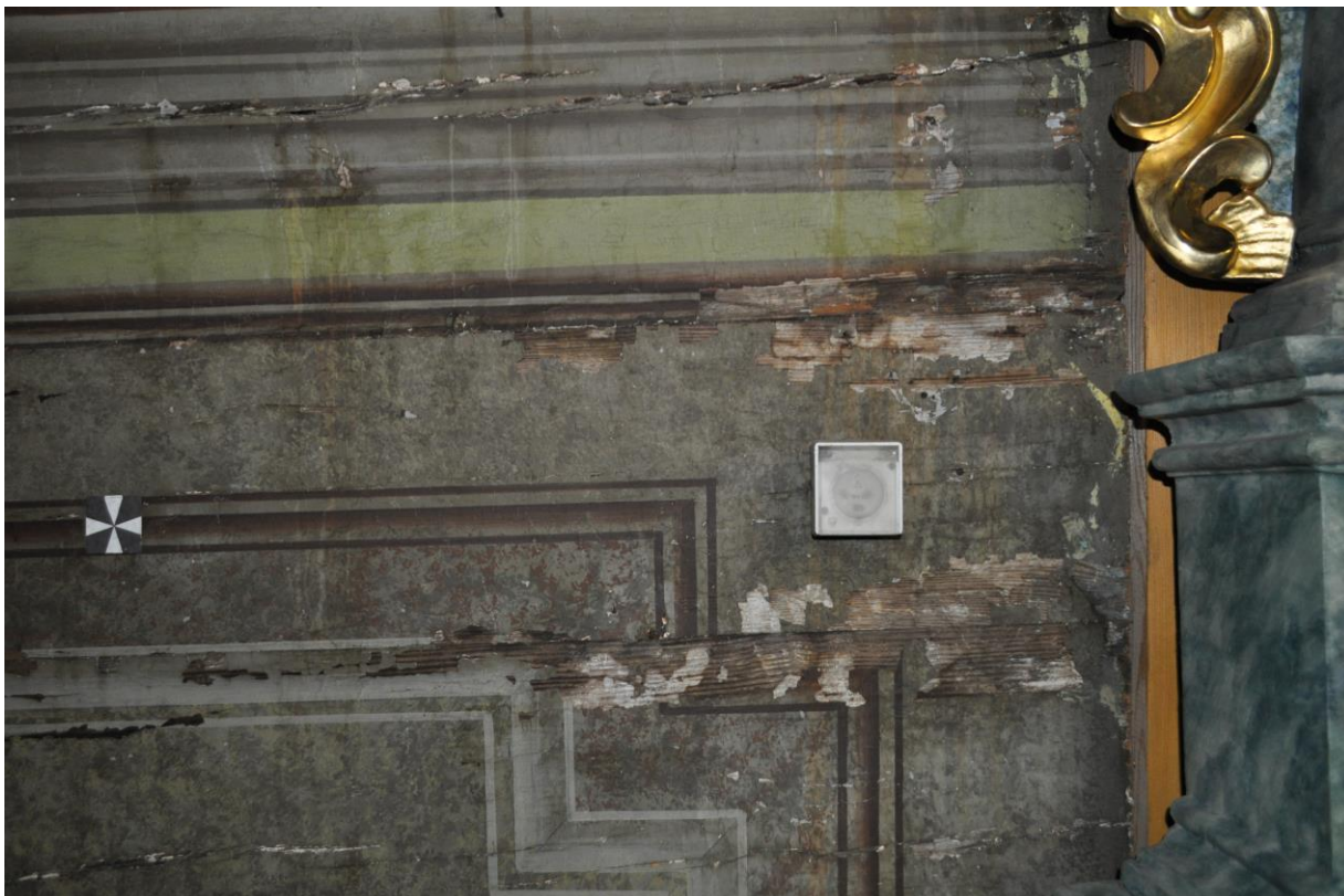
Fot. 15 Kościół p.w. Św. Mikołaja w Truskolasach. W partii cokołowej rozspojenia drewna na połączeniach belek z odpadającym kitem wypełniającym szczeliny. Uszkodzenia warstwy malarskiej.
