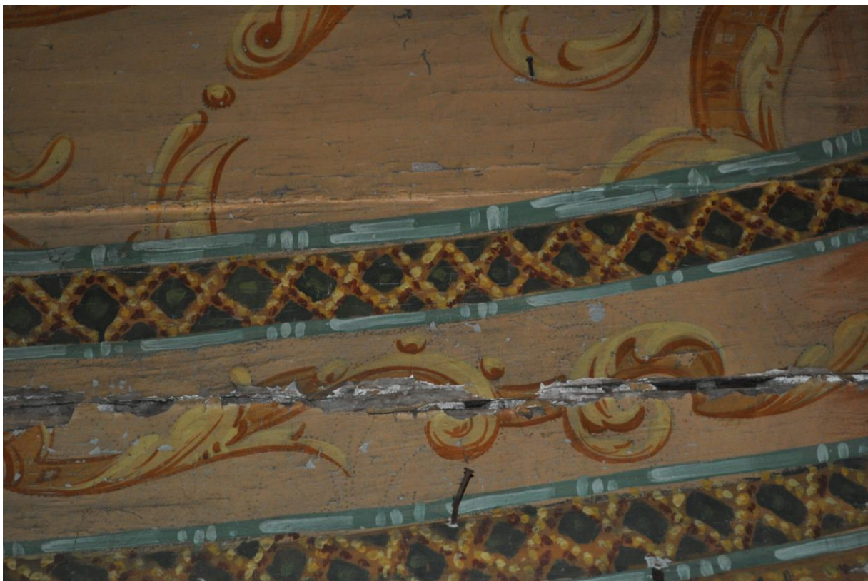
Fot. 16. Kościół p.w. Św. Mikołaja w Truskolasach. Ubytki, spękania i odspojenia warstwy malarskiej.
