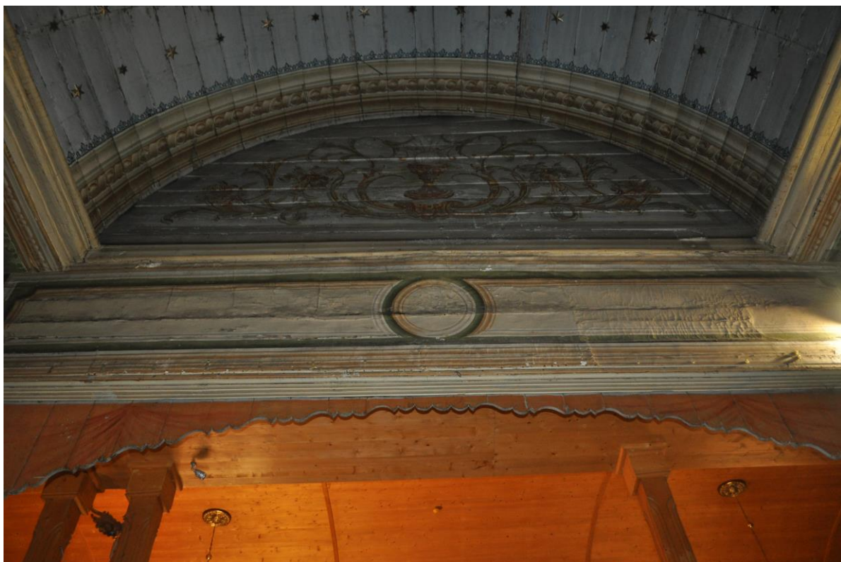
Fot. 11. Kościół p.w. Św. Mikołaja w Truskolasach . Ściana tarczowa nad wejściem do kaplicy. Odspojenia i ubytki powłok barwnych odsłaniające powierzchnię drewna. W partii gzymsu widoczne pęcherze.
