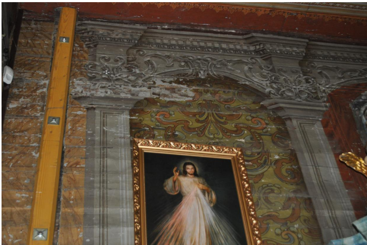
Fot. 5. Kościół p.w. Św. Mikołaja w Truskolasach. Rozspojenia na połączeniach drewna. Wokół połączeń odspojenia i ubytki kitów. Na całej powierzchni odspojenia i ubytki dekoracji barwnej o zróżnicowanym zasięgu.
